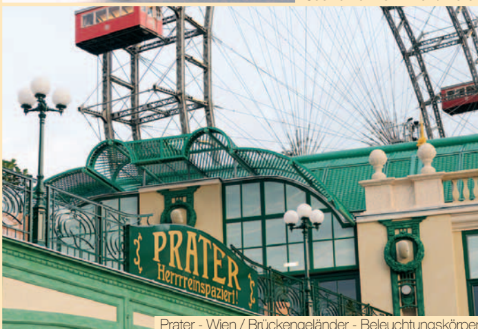
Prater - Wien / Brückengeländer - Beleuchtungskörper
