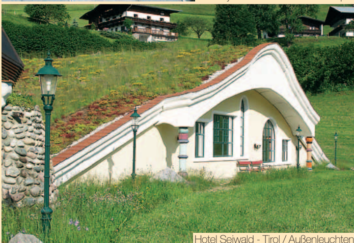
Hotel Seiwald - Tirol / Außenleuchten
