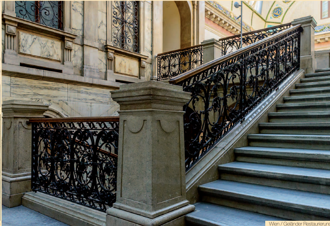
Wien / Geländer Restaurierung
